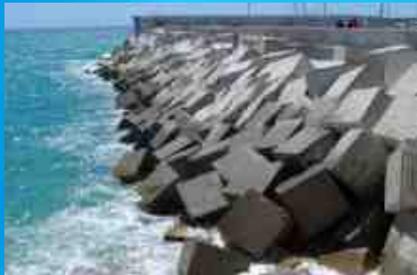
Obras de defensa
