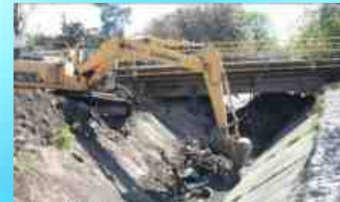
Aterramiento y colmatación de acueductos y canales
